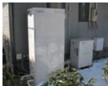
△実証試験中のエネファーム
