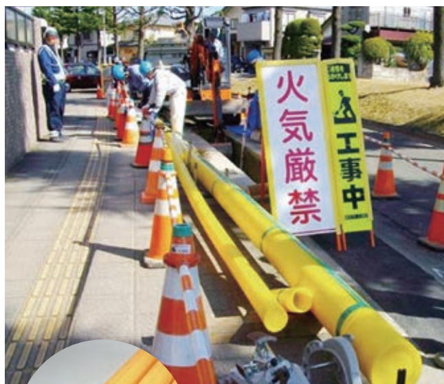
敷設作業の様子▲
