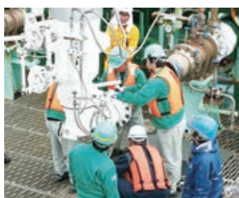
LNGの受入作業▲
