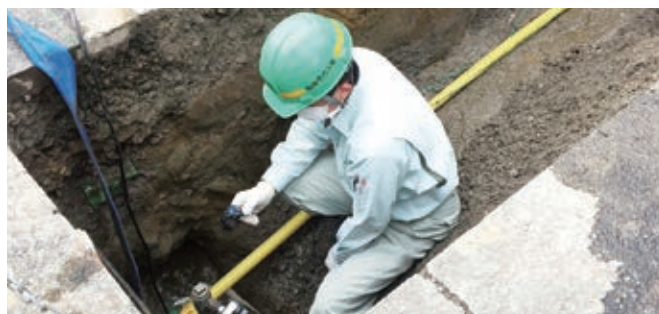
ガス管取替工事の検査▲
