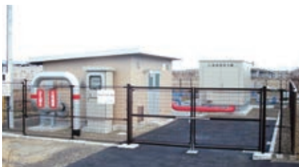
バックアップステーション外観▲
