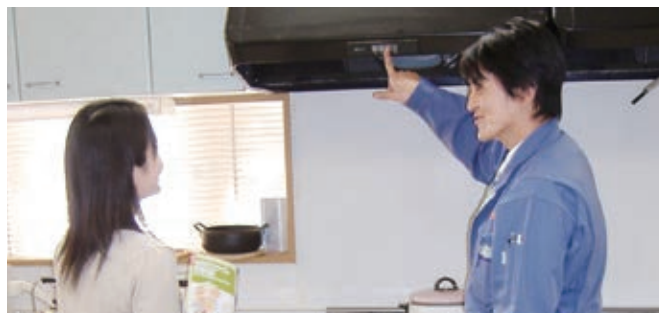
ガス設備点検の様子▲
