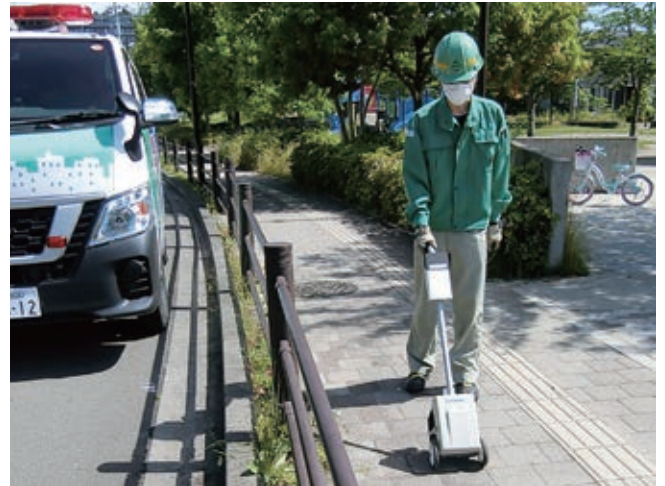
導管漏えい検査▲
