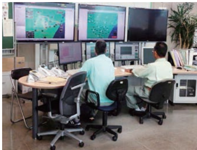
幸町コントロール室▲
