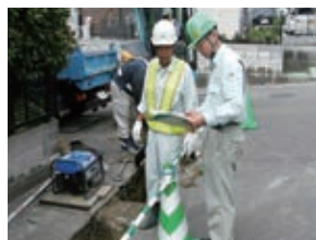
現場パトロールの様子▲
