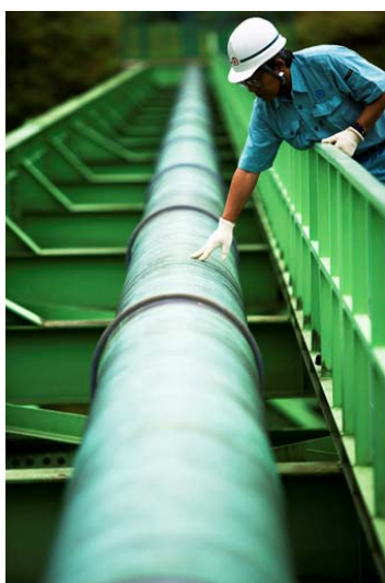
▲新潟～仙台パイプライン (石油資源開発㈱所有)
