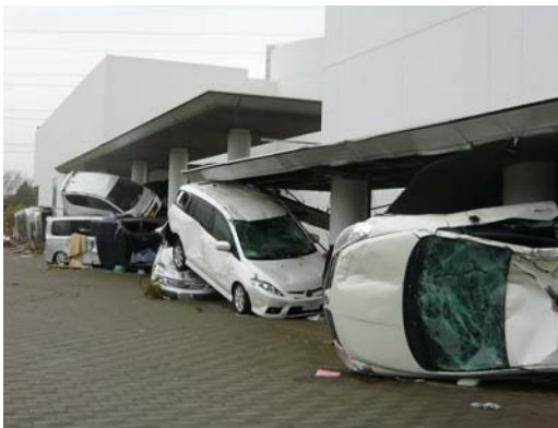
▲車が流入した港工場管理棟外観
