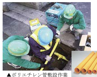
▲ポリエチレン管敷設作業
