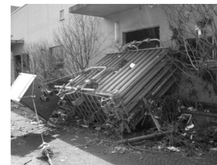
▲被害状況・多賀城倉庫
