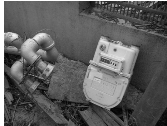
▲津波により破損したガスメーター(若林区荒浜)
