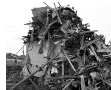
▲被害状況・第三特定製造所
