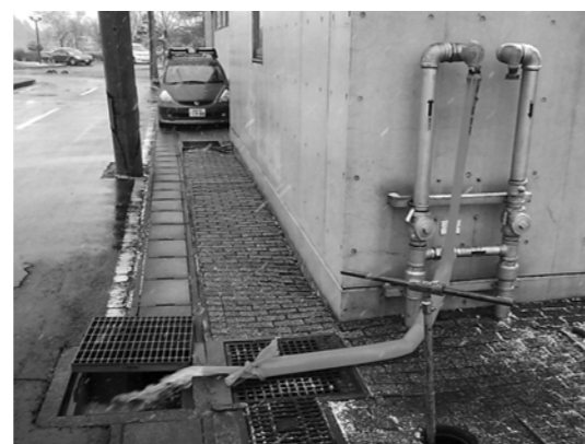
▲被害状況・地震被害による差し水状況②
