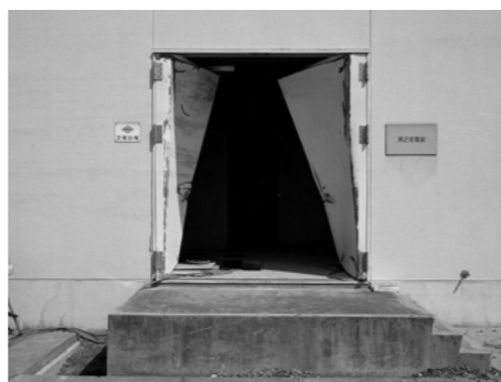
▲破損して海水が流入した第2変電室の扉
