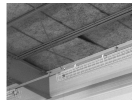
▲被害状況・幸町三丁目部品倉庫
