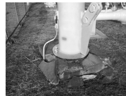
▲被害状況・球形ガスホルダー (アンカーボルトの伸び、基礎部の亀裂)
