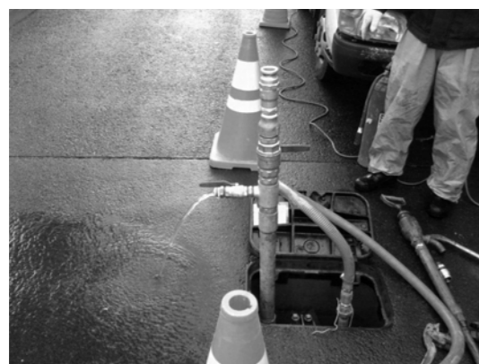
▲被害状況・地震被害による差し水状況①
