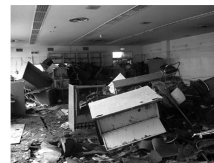
▲被害状況・多賀城倉庫
