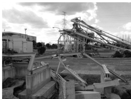
▲支持基礎ごと流されて損壊した LNG 出荷用配管
