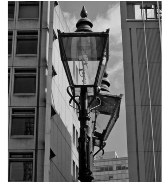
▲灯具が傾いたガス灯
