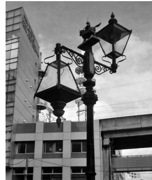
▲灯具が折損したガス灯
