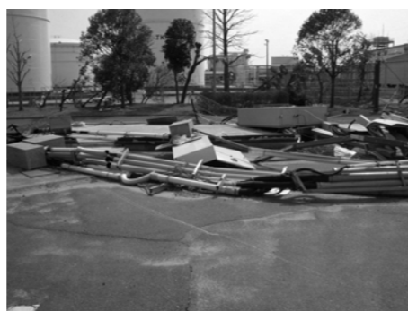
▲流出した LNG 出荷管理棟 (CNG 充填所と兼用)
