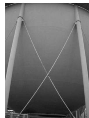
▲被害状況・球形ガスホルダー (タイロッドの伸び)
