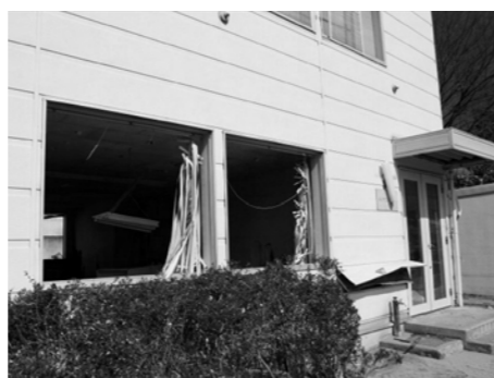
▲1階部分が損壊したメンテナンスセンター
