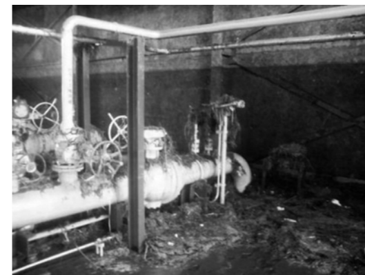
▲被害状況・ガバナ (設備の浸水)
