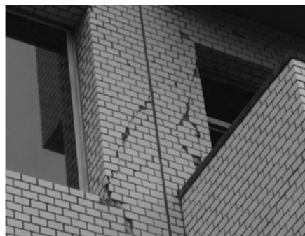
▲被害状況・東庁舎
