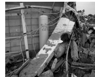
▲被害状況・第二特定製造所
