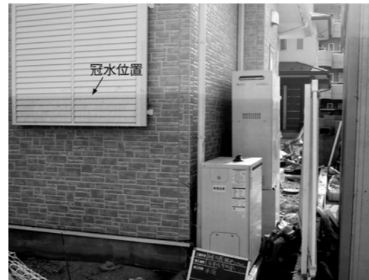
▲被害状況・津波による冠水
