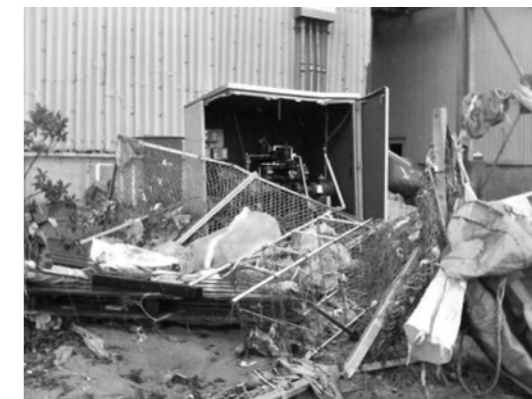
▲被害状況・ガバナ (津波漂流物による被害)
