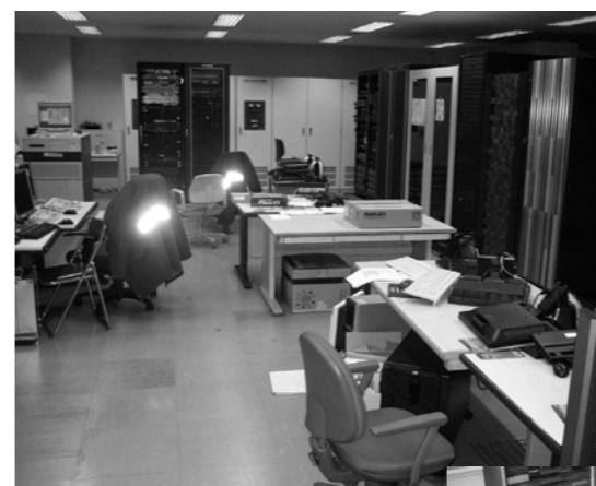
▲免震や転倒防止措置などの地震対策が功を奏して、ホストサーバなど主要設備は無傷。復旧活動の迅速な再開に貢献した。
