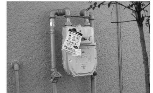
▲閉開栓作業の進行における最大の壁は、避難等によって多くの需要家が不在だったことだった。閉開栓時にはオートロックの門扉や屋内メーターが開けられず、やむなくガス管を切断する処置も行った。開栓時には立ち会いが必須であるため、ガス局全体で広報を行うとともに開栓班でも独自に告知ビラを作成・配布して、需要家の在宅率向上に努めた。写真は閉栓済みを示す使用禁止テープ。
