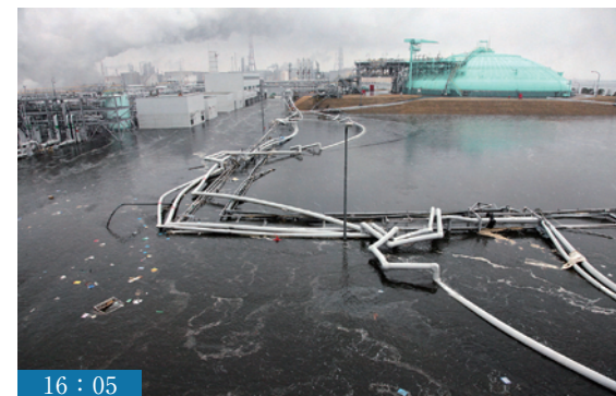
◀▼ 15時55分頃に最大水位を記録した津波は次第に引き始め、16時を過ぎてからは徐々に被害の状況が確認できるようになる。生命の危機と向き合った十数分間。鯨のようにジグザグに折れ曲げられた配管が津波の恐るべき威力を物語る。だが、新潟からのパイプラインの被害が少なかったことが早期の供給再開をもたらした。
