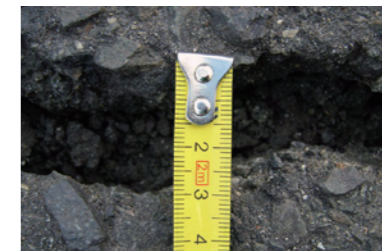
◀泉営業所の建物周囲に見られた陥没は数 cm にも及んだ。
