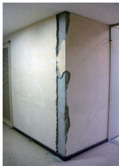
▲ガス事業の中枢を司る幸町庁舎は業務に支障をきたすような被害は無かったものの、5階会議室の下り天井の一部が落下および落下寸前になったほか、壁の亀裂やタイルの落下が各所で発生した。
