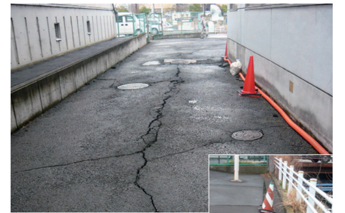
▲幸町庁舎の敷地内の各所で生じた亀裂と陥没。
