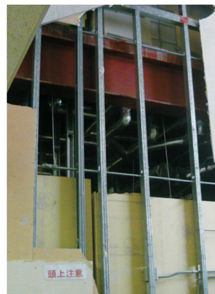
▲技術センターは壁ボードの落下や床への亀裂等が発生し、特に階段部分の被害が大きかった。
