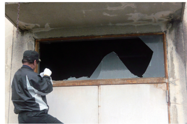
▲窓が割れたコントロール室。供給管理棟（東庁舎・西庁舎）の窓は飛散防止フィルムの効果のためか破損は見られなかった。
