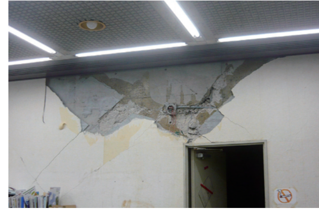
▲壁ボードの一部が落下した都市エネルギー営業課。壁ボードの落下や床の亀裂は庁舎内の各所に見られた。
