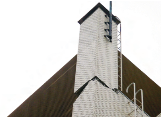
▲供給管理棟（東庁舎）の煙突がねじ曲がり、倒壊の恐れが生じた。
