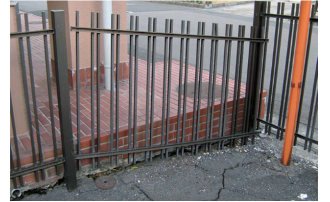
▲アスファルト路面の陥没により建物基礎との間に亀裂が生じた泉営業所。その影響で外柵の一部が変形し、傾いた。
