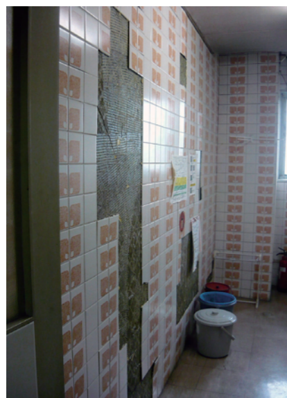
▲ガス事業の中枢を司る幸町庁舎は業務に支障をきたすような被害は無かったものの、5階会議室の下り天井の一部が落下および落下寸前になったほか、壁の亀裂やタイルの落下が各所で発生した。
