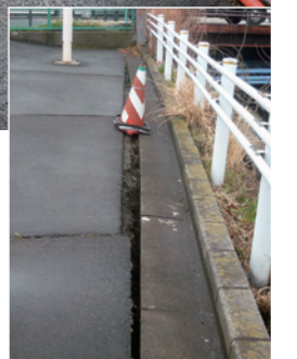
▲幸町庁舎の敷地内の各所で生じた亀裂と陥没。
